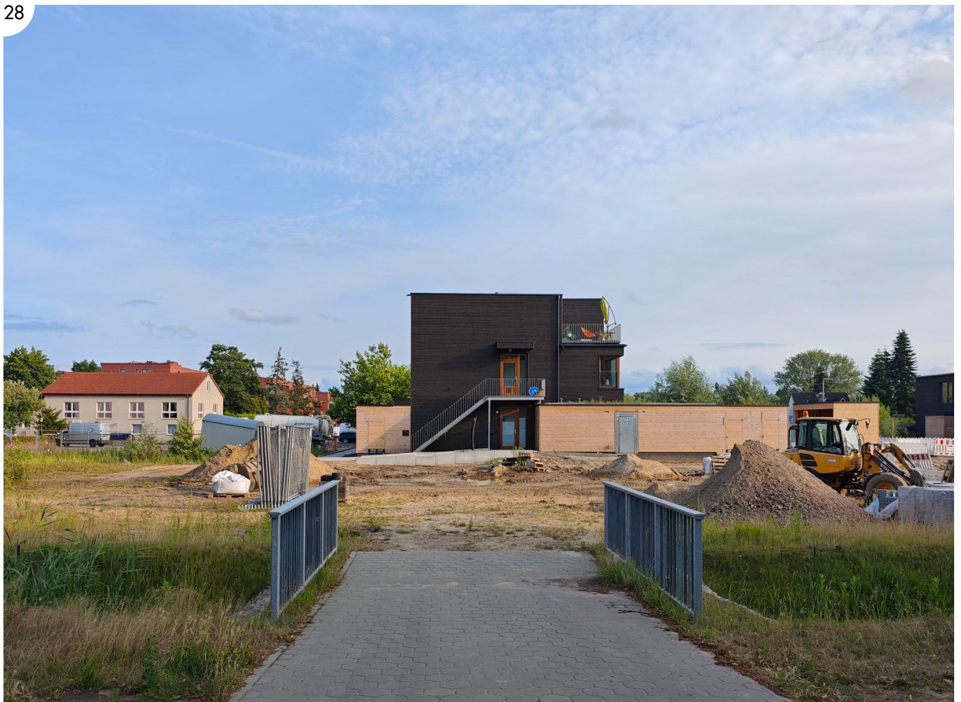
Baustelle in Georgswerder. (Bild: Treibholz)
